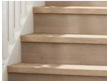
Stusstrinn i samme tresort
